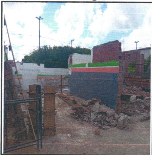
FOTO - DEMOLIÇÃO DE PISO DE CONCRETO SIMPLES, DE FORMA MANUAL, SEMREAPROVEITAMENTO. AF_09/2023
